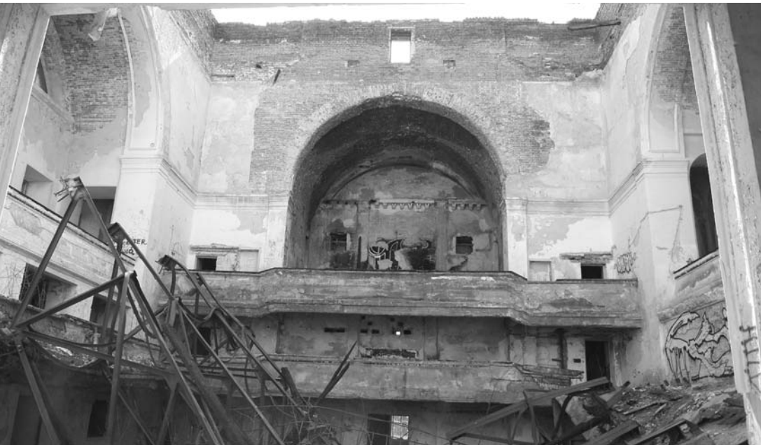
Фото 3. Руїна актової зали (колишнє приміщення церкви). Фото А. Ароян
