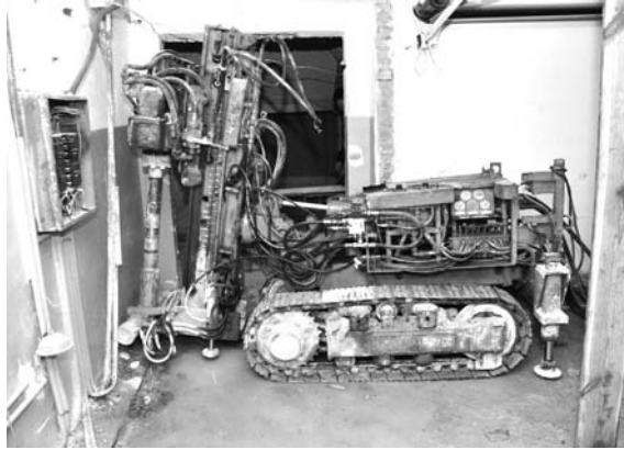
Фото 3. Будівельна техніка у приміщенні Гостиного двору.
