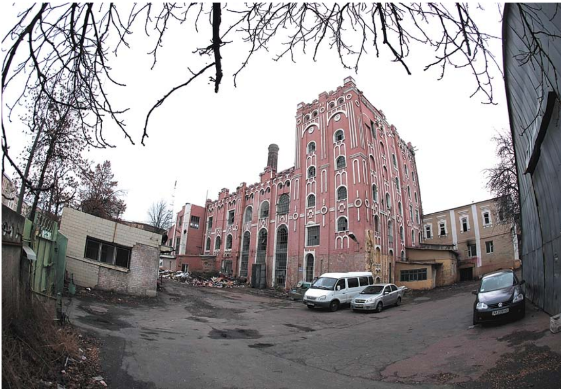
Фото 1. Головна будівля Фрунзе, 35.
