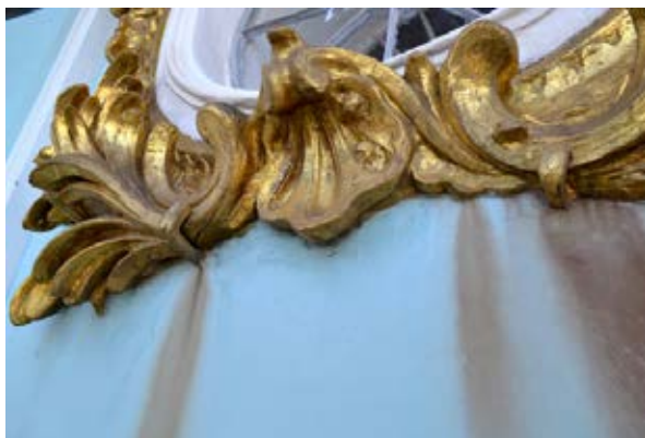
Рис. 19. Бурі патьоки на стіні від позолоченого декору люкарни. 2015 р.
