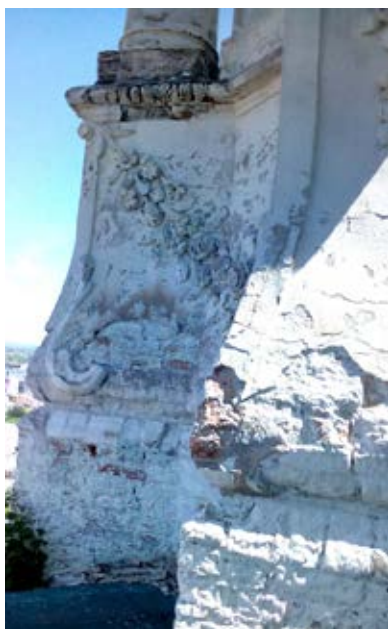
Рис. 20. Стан ліпного декору та отинькованої поверхні декоративних веж церкви. 2015 р.
