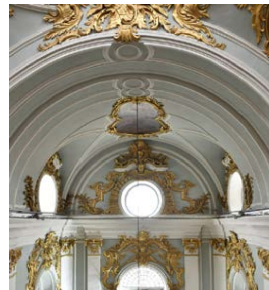
Рис. 47. Відреставровані елементи ліпного гіпсового декору на тлі відновлених історичних кольорів пофарбування інтер'єру Андріївської церкви. 2020 р.
