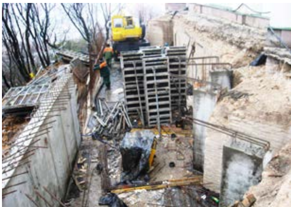
Рис. 16. Початок зведення залізобетонної підтримувальної плити паперті. 2009 р.
