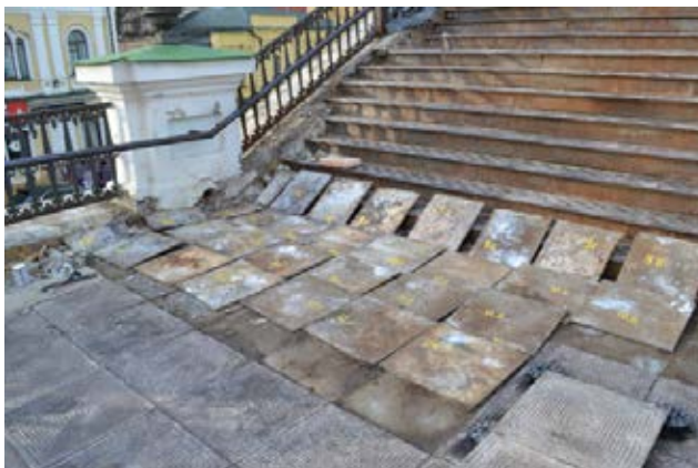
Рис. 22. Маркування чавунних плит сходів під час демонтажу для реставрації. Листопад 2015 р.
