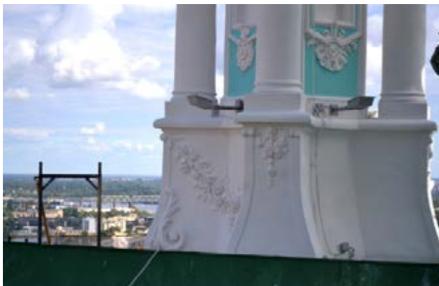
Рис. 21. Стан ліпного декору та отинькованої поверхні декоративних веж церкви (після реставрації). Червень 2015 р.
