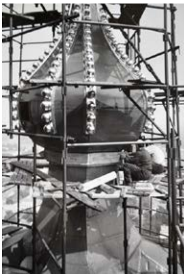
Рис. 11–12. Ремонтно- реставра- ційні роботи 1979–1988 рр. в Андріївській церкві
