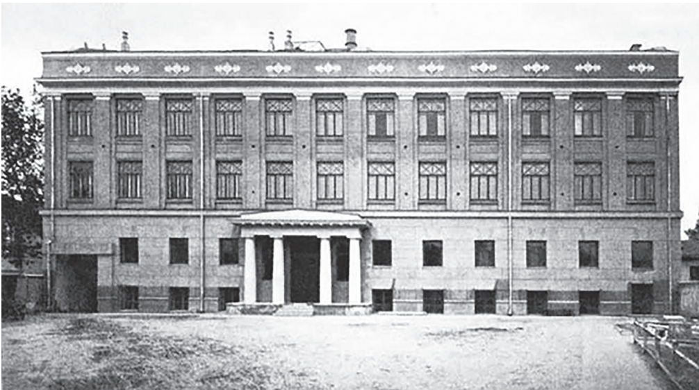
Фото 2.2. Будівля гімназії Аделаїди Жекуліної. Бл. 1912 р.
